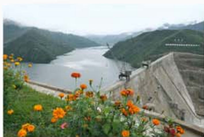
Во всех уголках страны построены ГЭС.
